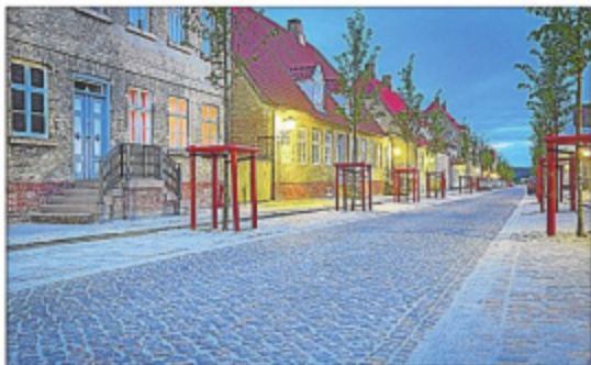
Nørgaard Anlæg har blandt andet udført gaderenoveringen i den historiske by Christiansfeld i Sønderjylland, (Pressefoto)
